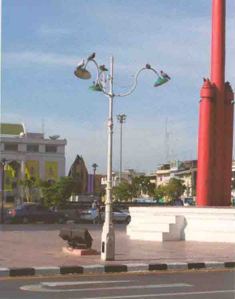
เสาโคมระยงเสาชิงช้าสร้างในรัชสมัยที่ 5 Lampost near the Giant Swing, probably erected in the reign of King Rama V
